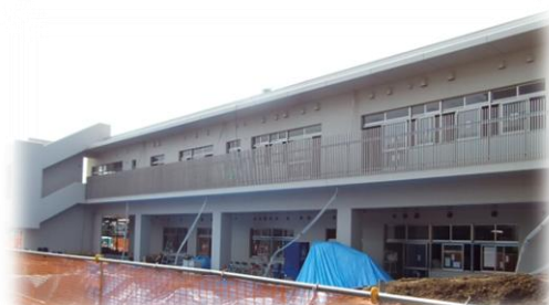
平成 27 年 7 月 校舎北側より
